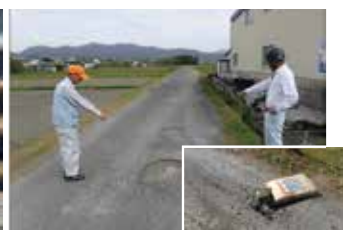
農道の軽微な補修
