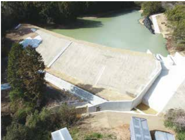
農業用ため池整備（御浜町）
