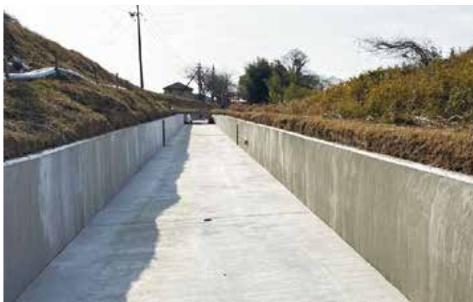
農業水利施設の長寿命化（伊賀市）
