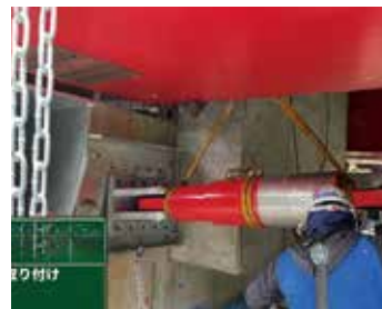
※上の写真は他工事のものです。
