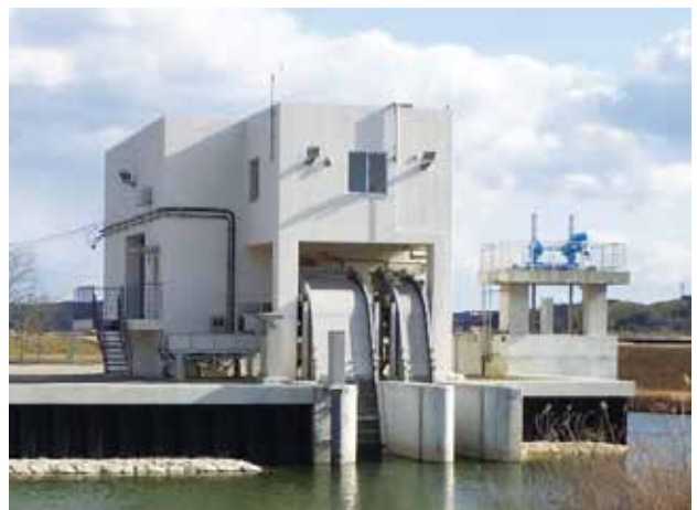
排水機場の整備（志摩市）
