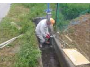
水路の軽微な補修
