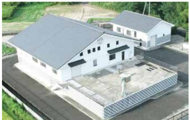
集落排水施設の整備（伊賀市）
