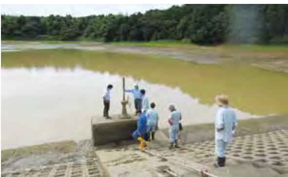
施設点検の様子
