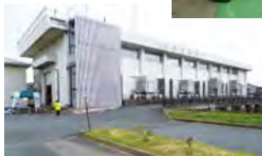
事業視察の様子(大和田排水機場)
