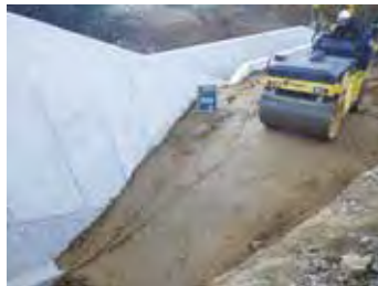
堤体盛土転圧状況
