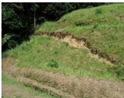
堤高が高く、法長も大きいが堤体全体の草刈りが綺麗にされていて一目で異常があるかを確認することが出来る
