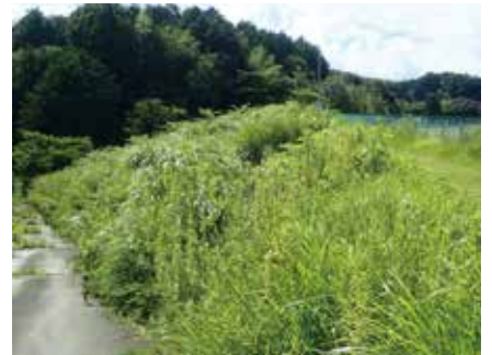
堤体下流法面も草だらけで地表面がわからなくなっている
