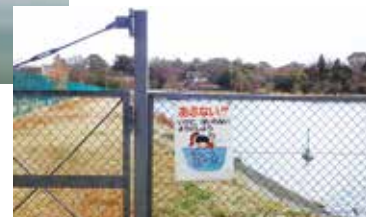
注意看板設置状況
