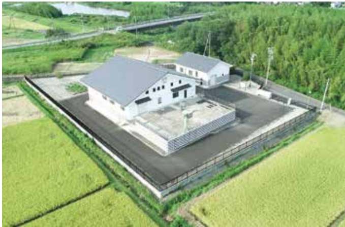
農業集落排水施設 (伊賀市：神戸地区)
