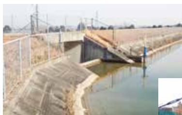
安全柵設置状況（松阪市）
