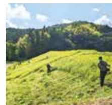
法面除草作業
