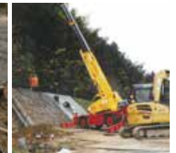
水路法面補修
