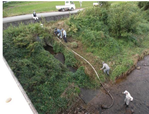
給水ポンプ設置・撤去
