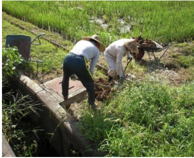
給排水路土砂上げ
