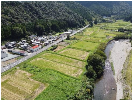
ドローン空撮(南中村地区)
