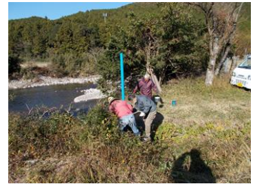
頭首工の点検
