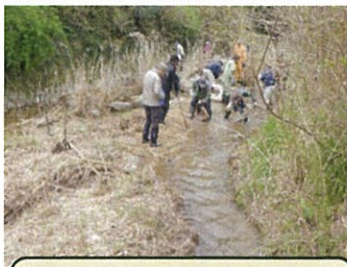
取水口の泥上げ 音羽支部
