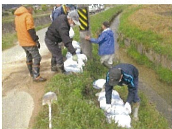
異常気象後の応急処置 杉谷支部
