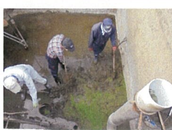
調圧水槽の泥上げ 榊支部
