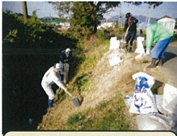
排水路法面修復作業 神森支部
