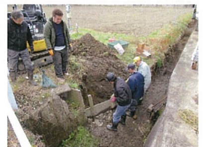
倒壊水路壁の補修
