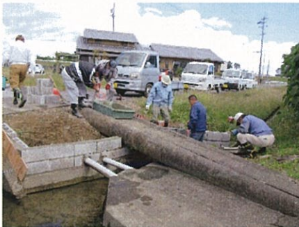
水路壁の嵩上げ
