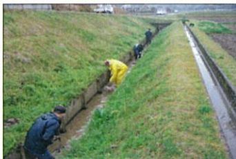
水路の泥上げ
