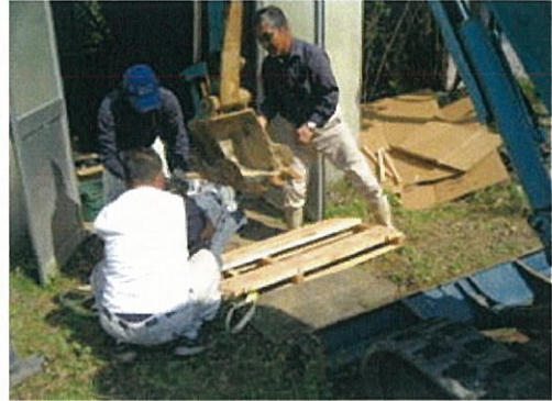
ポンプの更新
