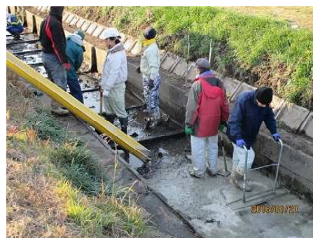
コンクリート底打ち
