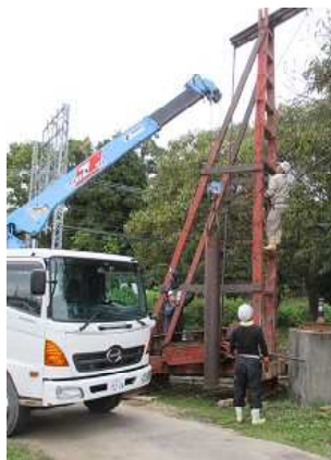
ポンプの更新工事
