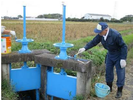
水門の錆止め処理（ペンキ塗装）
