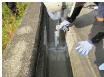
シーリング材注入
