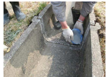
コロボンド 65 施工状況
