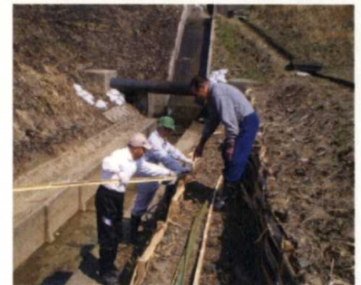
【しがらみ（柵作成工法）】
