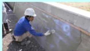
老朽化した水路壁のコーティング
