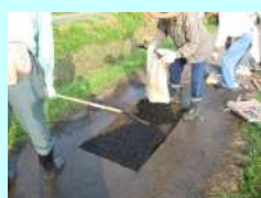
農道の部分補修
