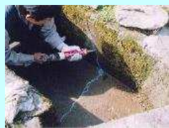
水路のひび割れ補修
