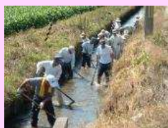
水路の泥上げ
