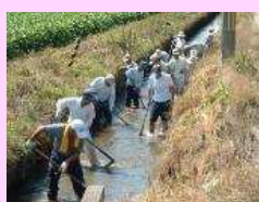
水路の泥上げ
