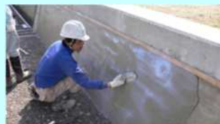
老朽化した水路壁のコーティング
