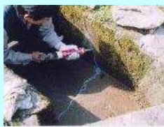
水路のひび割れ補修
