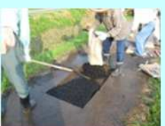
農道の部分補修
