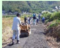
未舗装農道の舗装
