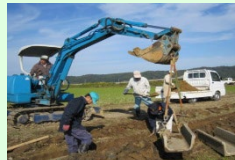
コンクリート水路の更新
