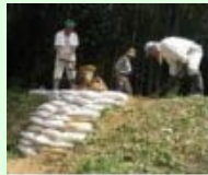
漏水箇所の補修
