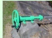
ゲート、バルブの更新
