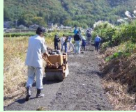
未舗装農道の舗装
