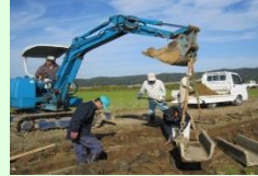
コンクリート水路の更新
