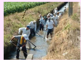
水路の泥上げ
