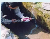
水路のひび割れ補修
