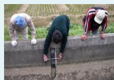
施設の機能診断
