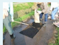
農道の部分補修
