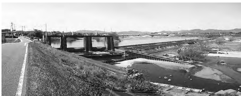
鈴鹿用水第一頭首工
