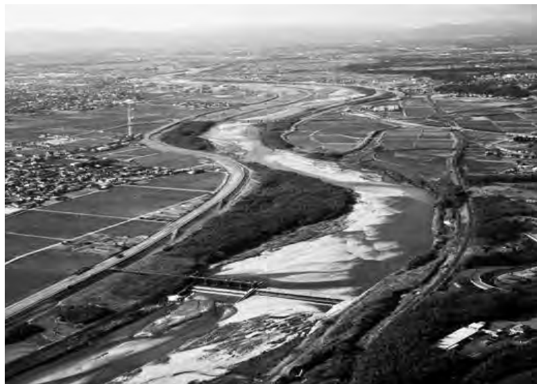
改修計画が予定されている鈴鹿用水第二頭首工
