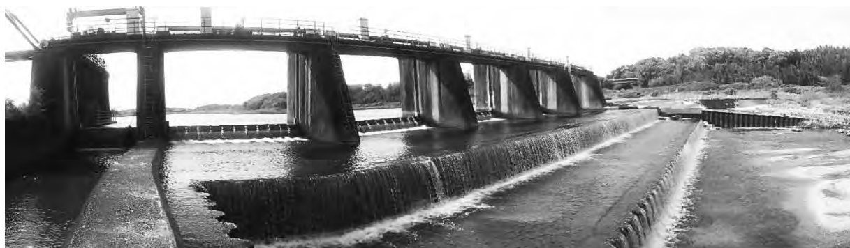
鈴鹿用水第二頭首工
