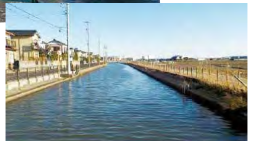
中央幹線排水路
