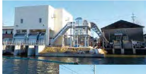
川先排水機場
