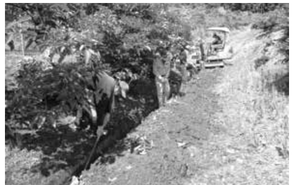
多面的機能支払での活動(水路の泥上げ)
