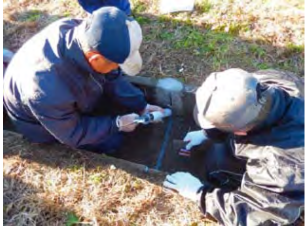
シーリング材注入工法
