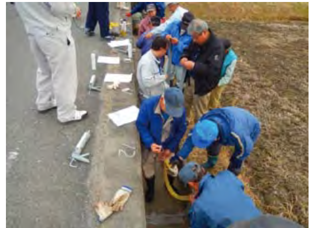
粘着型テープ被覆工法
