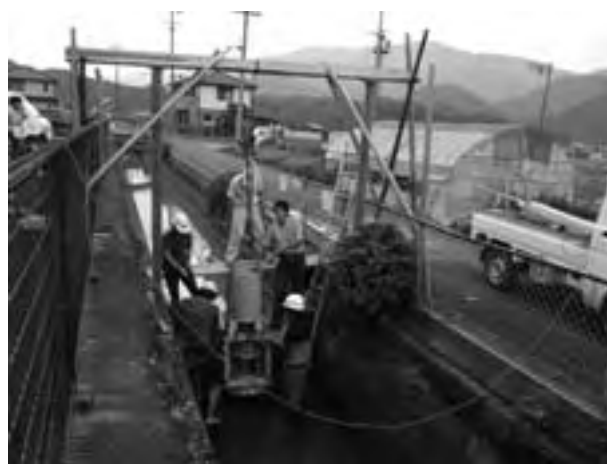
発電機据付作業
