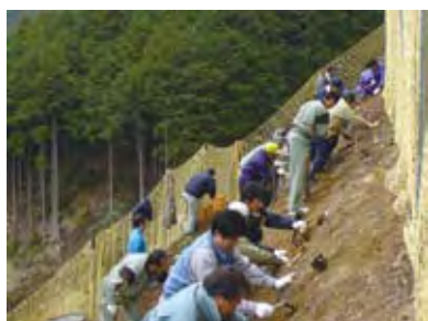
急斜面での植樹
