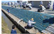
水路法面へ花植栽
