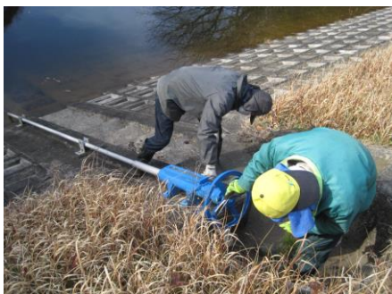
ため池ゲートの修理塗装
