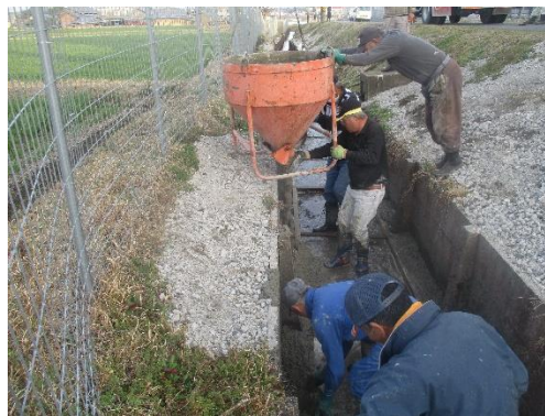
水路の補修(生コン打設)
