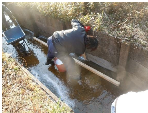
水路の補修作業
