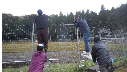
獣害防止柵設置
