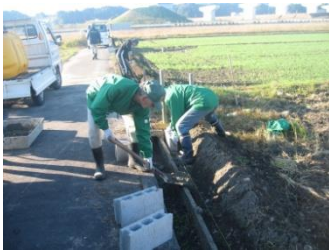
水路の嵩上げを実施
