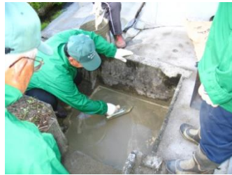
水路の補修を実施
