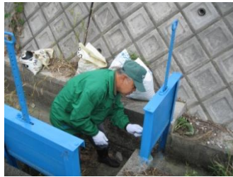
ゲートの補修を実施
