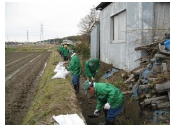
水路の泥上げを実施
