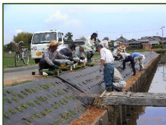
地域住民による防草シート張り とヒメイワダレソウの植栽
