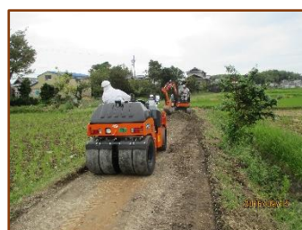
測量及び路床・路盤工事まではサポート隊で行う
