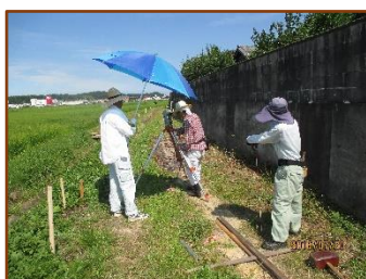
測量及び路床・路盤工事まではサポート隊で行う
