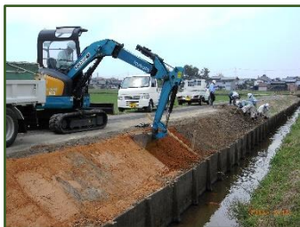
サポート隊による重機を使った法面整形
