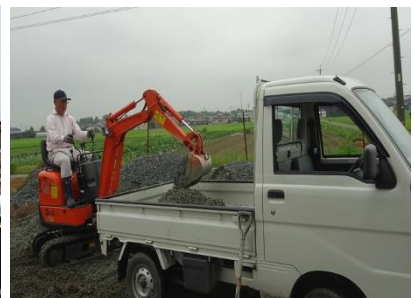
農道補修作業
