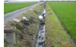
排水路の泥揚げ
