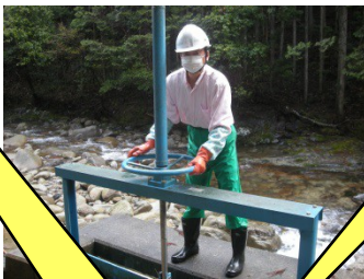
水路ゲートの油さし
