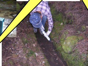
水路の目地づめ
