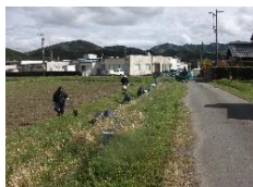
水路の泥上げ
