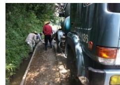
水路法面Co打設
