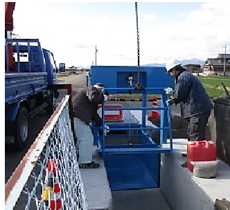
水路暗渠の更新
