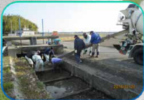
長寿命化活動(水路のコンクリート打設)
