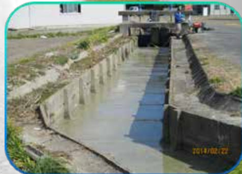
長寿命化活動(水路のコンクリート打設)
