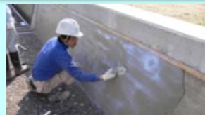
老朽化した水路壁のコーティング
