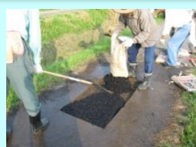
農道の部分補修
