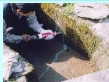
水路のひび割れ補修
