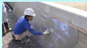
老朽化した水路壁のコーティング
