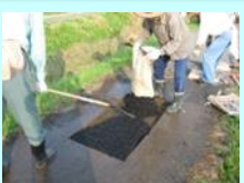
農道の部分補修
