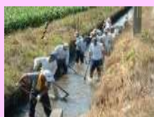
水路の泥上げ
