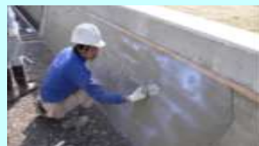
老朽化した水路壁のコーティング
