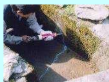
水路のひび割れ補修
