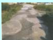
農道の窪みの補修
