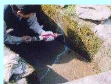
水路のひび割れ補修
