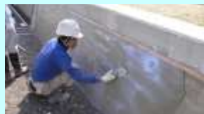
老朽化した水路壁のコーティング
