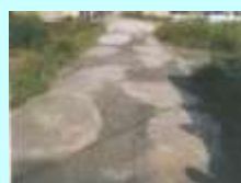
農道の窪みの補修
