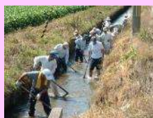
水路の泥上げ
