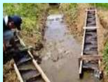
水田魚道の設置
