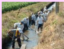
水路の泥上げ
