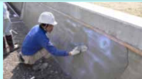
老朽化した水路壁のコーティング
