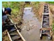
水田魚道の設置
