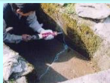
水路のひび割れ補修
