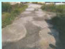
農道の窪みの補修
