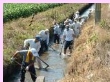
水路の泥上げ
