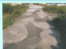
農道の窪みの補修
