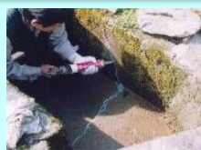
水路のひび割れ補修
