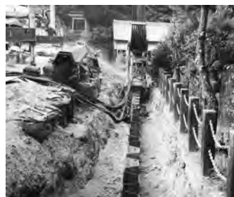
サイレントパイラーによる 鋼矢板打設完了 鋼矢板打設状況
