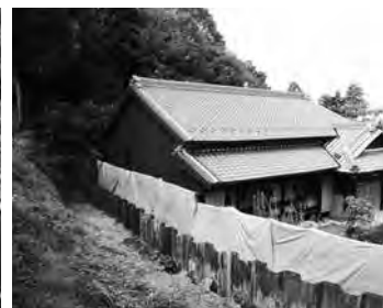
サイレントパイラーによる 鋼矢板打設完了 鋼矢板打設状況
