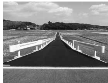
施工後の状況
