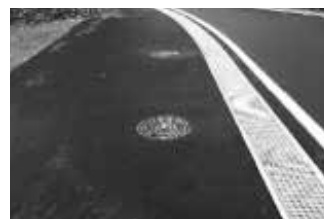
防火水槽完成
