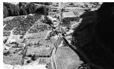
川瀬地区 完成写真
