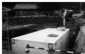
防火水槽据付状況
