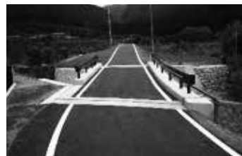
橋梁工完了後
