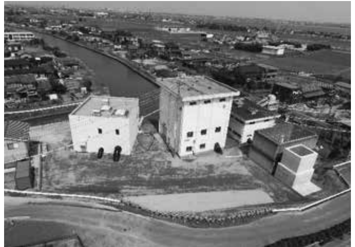
大島排水機場(左端が新しい排水機場)
