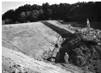
ため池の堤体改修
