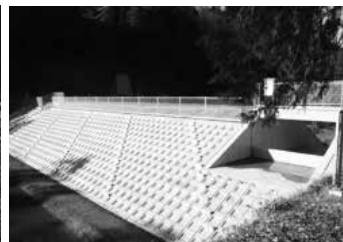
豪雨・耐震化対策済のため池
