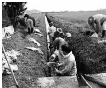
水路の泥上げ
