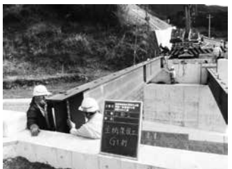
上部工架設状況
