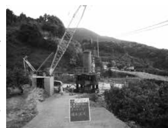
下部工杭打設状況
