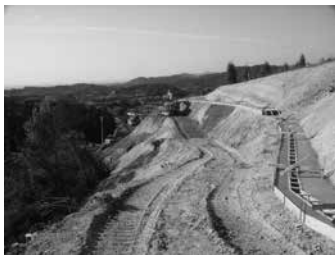
山側切土掘削状況
