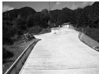
コンクリート舗装完了
