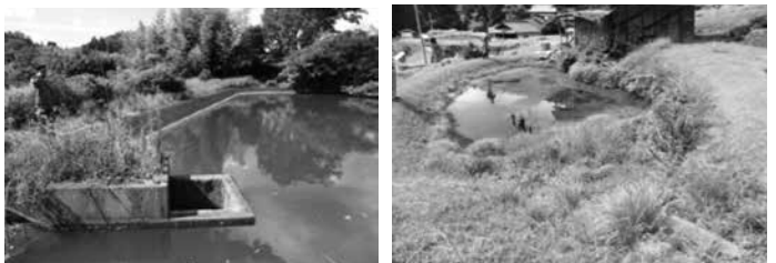
図-2 ため池点検状況(広島県東広島市内)
