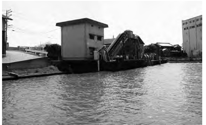
（写真1） 事業着手前の川先排水機場
