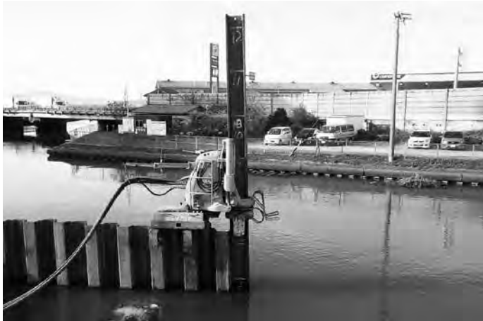
(写真3) 安全確認後の仮設矢板施工状況
