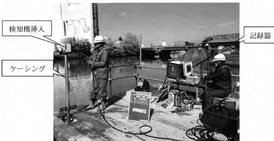
(写真6) 磁気探査状況(ジェットボーリング地点)
