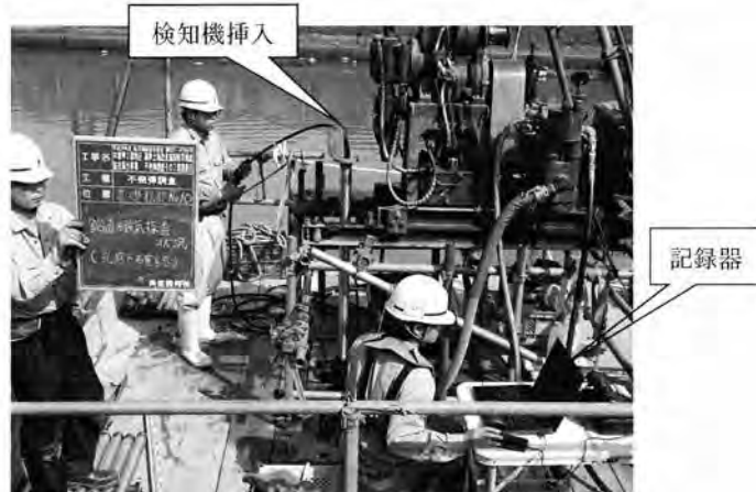
(写真5) 磁気探査状況(機械ボーリング地点)
