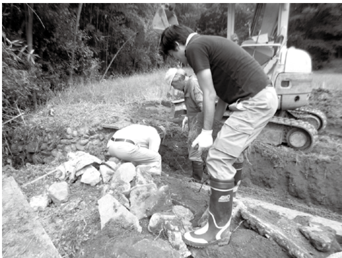
多面的機能支払活動実践(石積補修状況)
