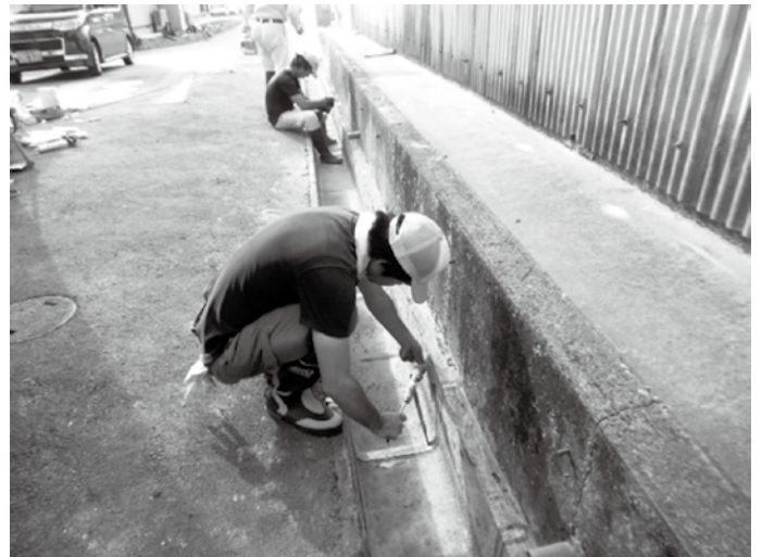
多面的機能支払活動実践(目地補修状況)
